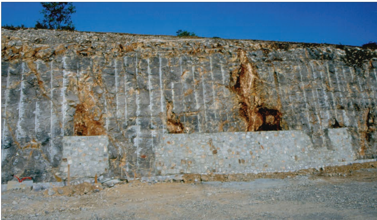
Slika 3.6: S skalnimi zidovi zaprte jame v brežini avtocestnega useka.
