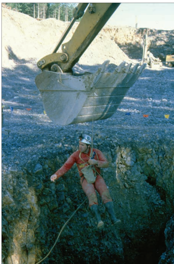
Slika 1.1: Raziskovanje jame, katere strop se je udrl zaradi miniranja med gradnjo avtoceste pri Divači.
