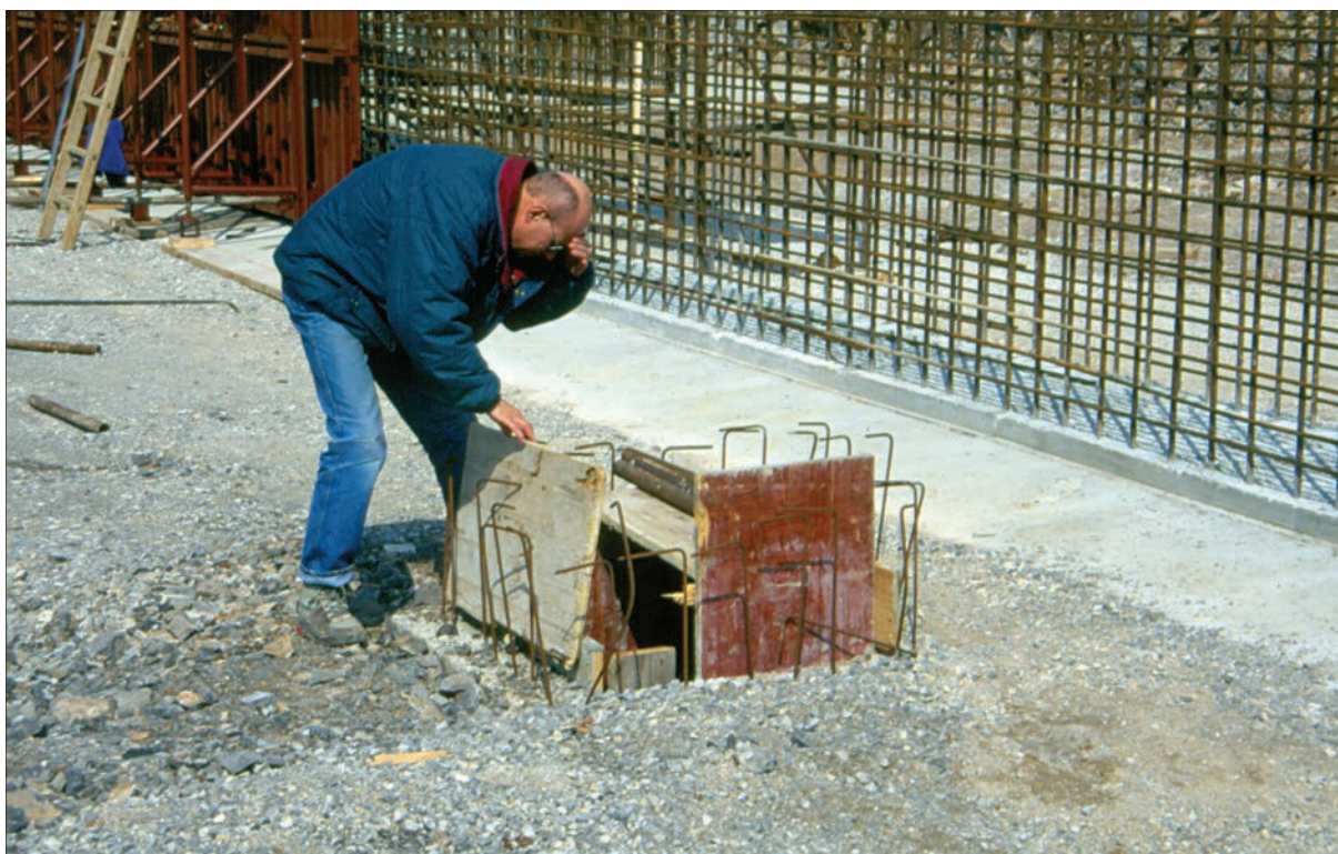
Slika 1.14: Gradnja umetnega vhoda ob cestišču.
