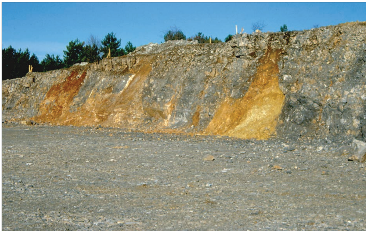
Slika 2.7: Jame, zapolnjene z naplavinami v brežini avtocestnega useka.
