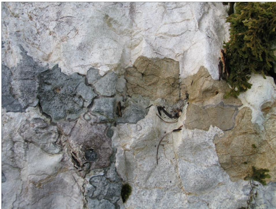
Slika 8.3: Biokorozijsko razjedena površina škrapelj.
