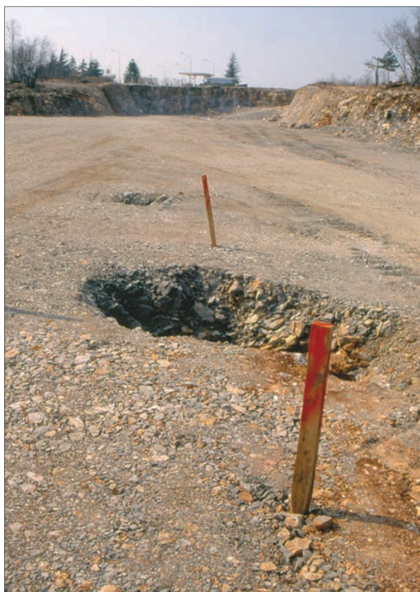
Slika 3.8: Pod tresočim valjarjem se je odprlo manjše brezno.
