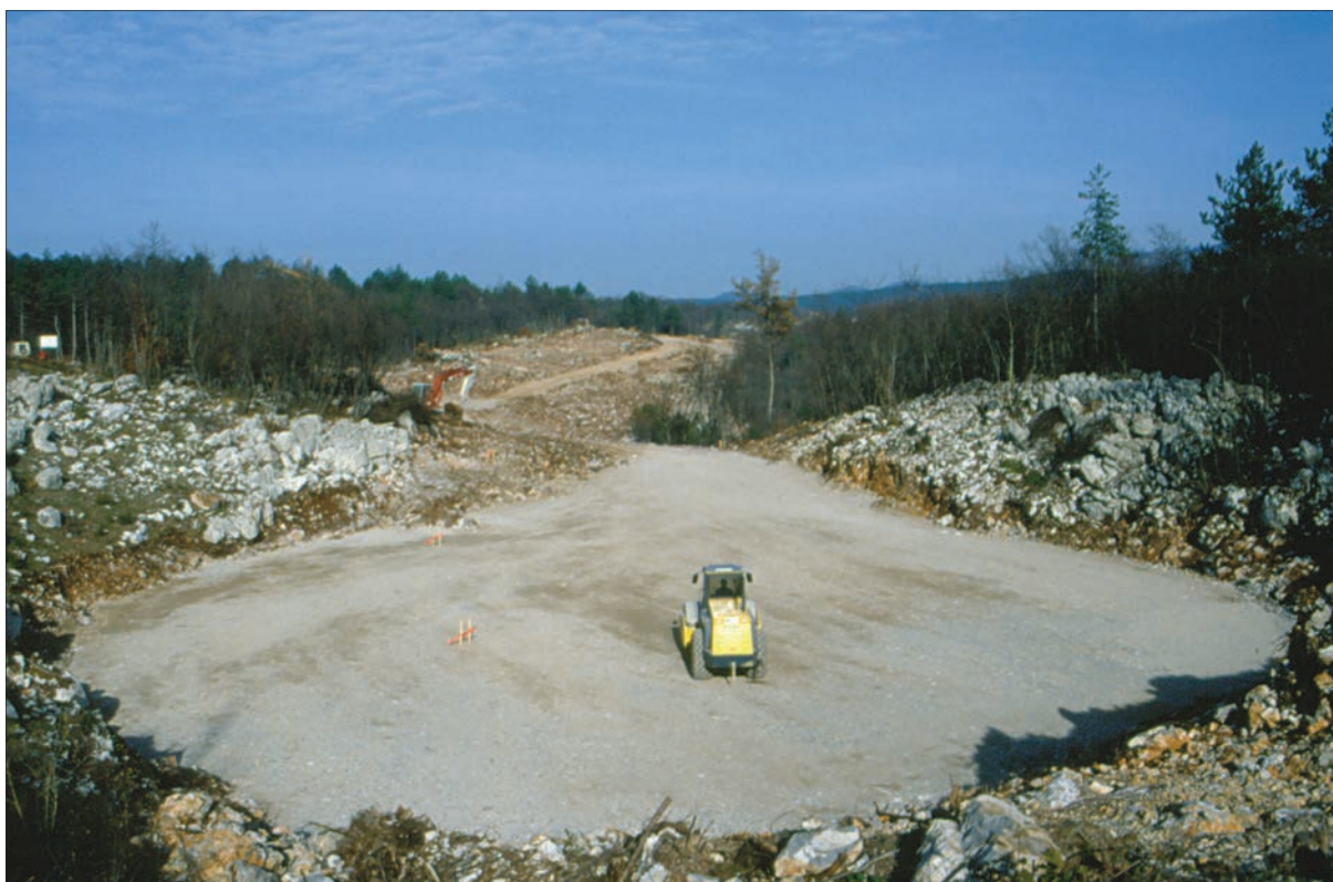
Slika 1.2: Zapolnjevanje vrtače z gruščem. Iz vrtače so najprej odstranili naplavine. Danes je pod avtocesto med Kozino in Divačo.
