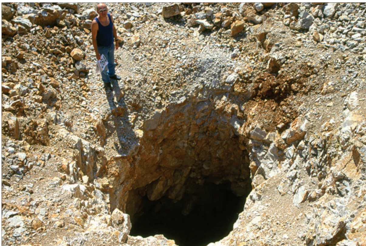
Slika 1.10: Udor stropa jame pri gradnji useka pri počivališču pri Divači.
