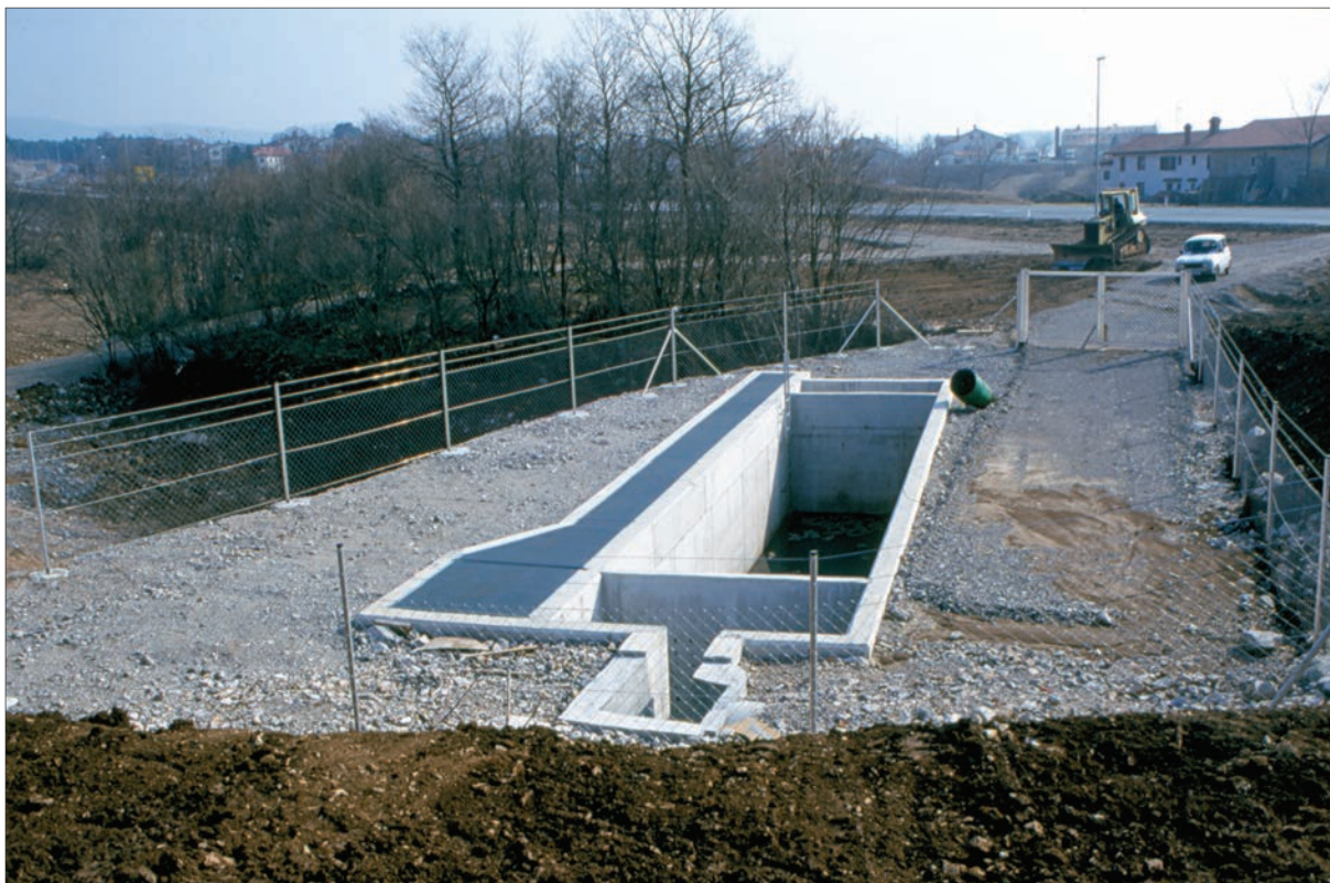
Slika 1.17: Gradnja lovilca olj.
