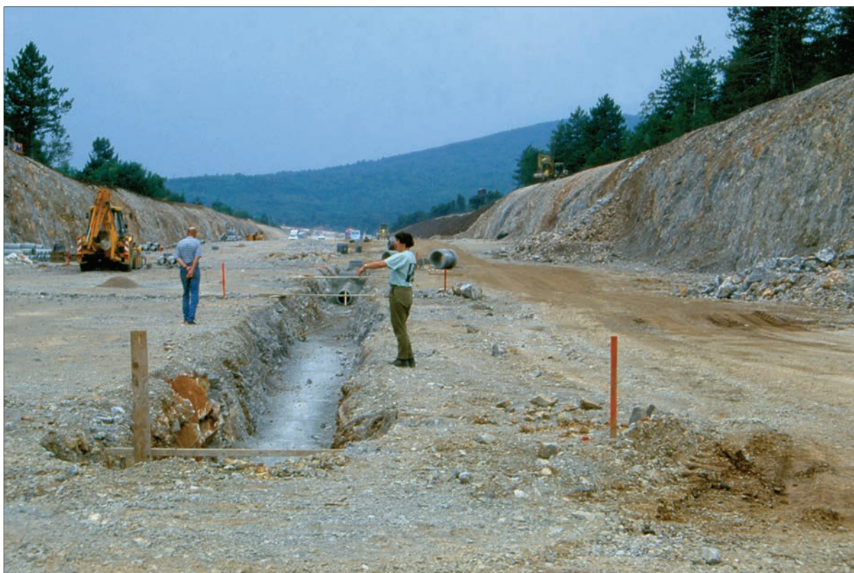
Slika 1.15: Priprava za polaganje cevi za odvodnjavanje cestišča.
