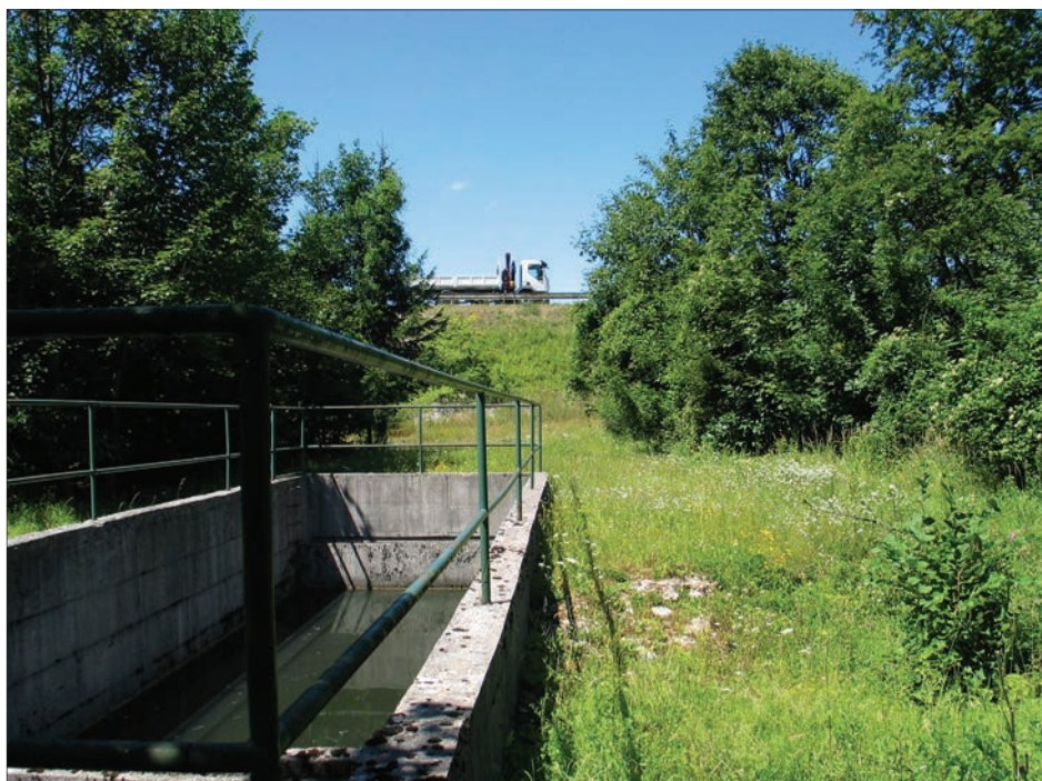
Slika 22.5: Lovilnik olj pri odcepu regionalne ceste Postojna–Planina za Unec, kjer poteka avtocesta po ravnem terenu.
