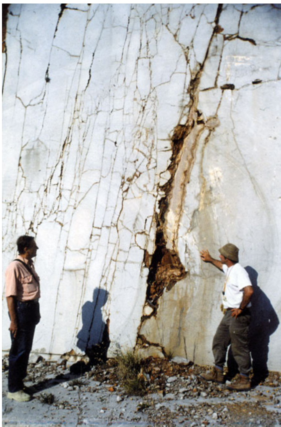
Slika 84: Korozijsko razširjene razpoke z odloženimi sigami v kamnolomu Lipica.
