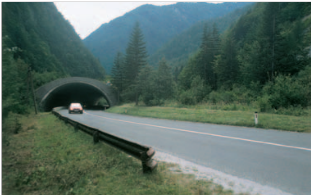
Slika 35: Magistralno cesto Tržič–Ljubelj ogroža Begunjski plaz. Zaradi pomembnosti so jo že kmalu po dograditvi trajno zavarovali z lavinskim predorom. Pokazalo pa se je, da so zgradili prekratkega, saj je v nekaj primerih plazovina zasula enega od obeh ali celo oba vhoda v predor.
