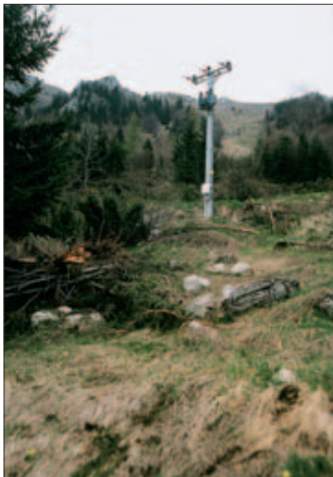
Slika 41: Snežni plaz nad Torko na južnem pobočju Ratitovca je ogrozil steber električnega daljnovoda že prvo zimo po njegovi postavitvi, zato ga bodo morali čim prej dodatno utrditi oziroma zavarovati.
