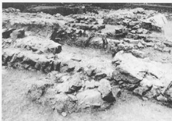
Abb. 127: Großes Gebäude. Durchgang vom Süd- zum Nebenraum, Detail.
