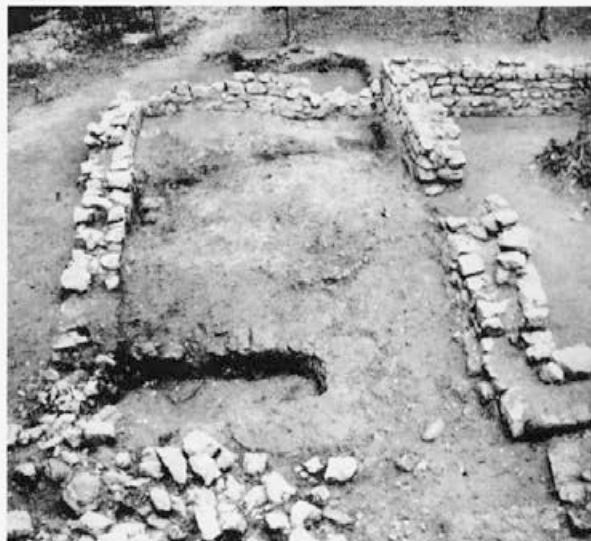
Sl. 52: Zgornja cerkev. Veža, pogled z juga. Abb. 52: Obere Kirche. Narthex, Blick von Süden.
