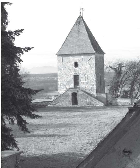
Sl. 54: Grajski grič na Ptuj; zahodni plato (Turnirski prostor). Pogled z vzhoda (foto S. Ciglencečki).
