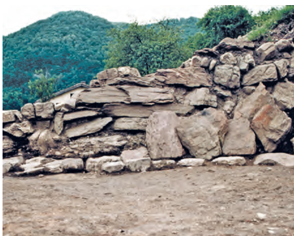
Sl. 105: Hiša 15. Pregradni zid; pogled z vzhoda.
