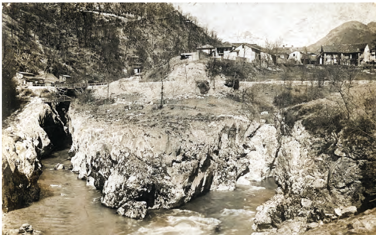
Sl. 3: Sotočje Idrijce in Soče, ko ga še ni zalilo akumulacijsko jezero doblarske elektrarne; razglednica iz leta 1916 (hrani Tolminski muzej).
