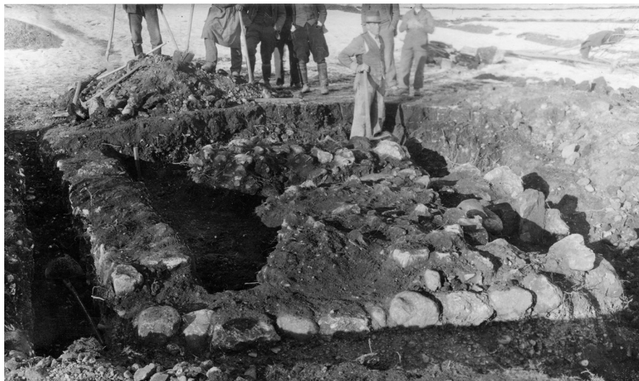
Sl. 9.23: Bled, Želeče. Izkopani jugozahodni vogal antične stavbe, pogled z juga. Foto: Arhiv AO NMS.
