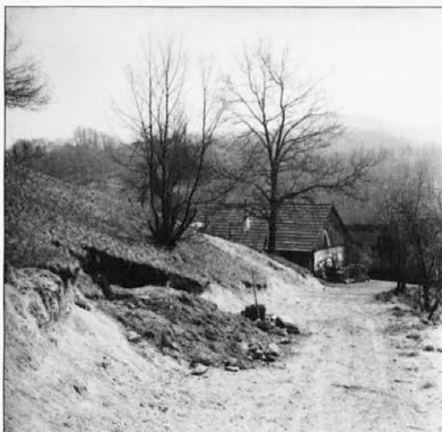
Sl. 12: Objekt 2 po izgradnji ceste. Abb. 12: Objekt 2 nach dem Straßenbau.
