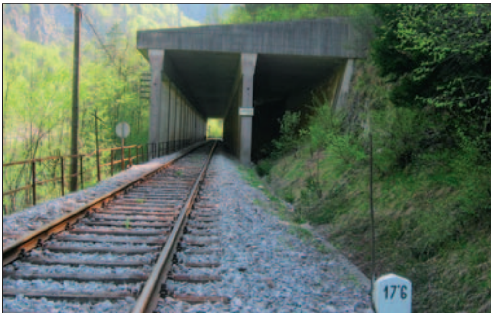
Slika 4: Edina lavinska galerija pri nas je na Obrnah na železniški progi Jesenice–Bohinjska Bistrica. Je okolju prijazen, a trajen objekt (fotografija: Miha Pavšek).
