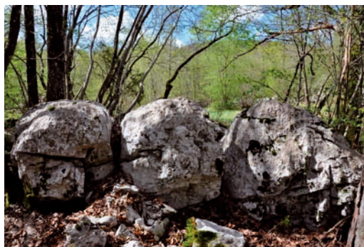
In še trije v zidu
