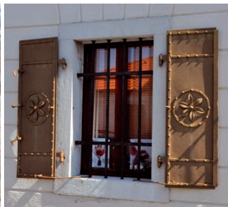
Kovane svarice na železnih polknicah na Praprotnikovi hiši v Lokvi
