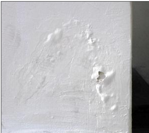
Slika 3: Odpadanje ometa in luščenje barve.
