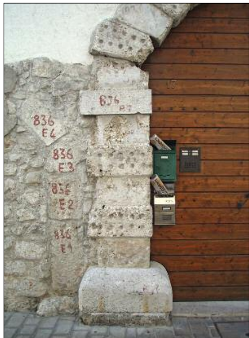
Slika 7: Številni klesani kamni še imajo oznake, na podlagi katerih so bili ob obnovi vzidani na mesta pred potresom.
