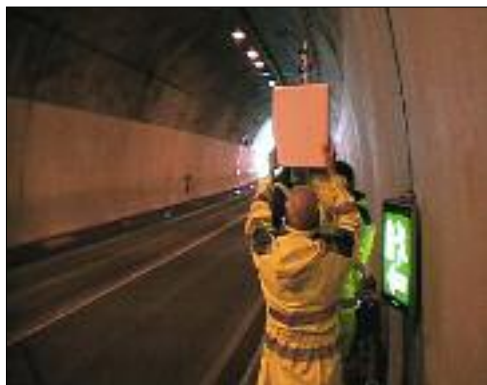
Slika 7: Montaža opreme v predoru Ljubelj.
