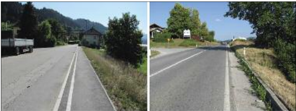
Slika 2: Ureditev nefunkcionalne kolesarske steze v obliki pločnika (slika levo) in konceptualna ureditev kolesarske povezave po zelo prometni cesti G1-1 (slika desno) (Rozman 2017).
